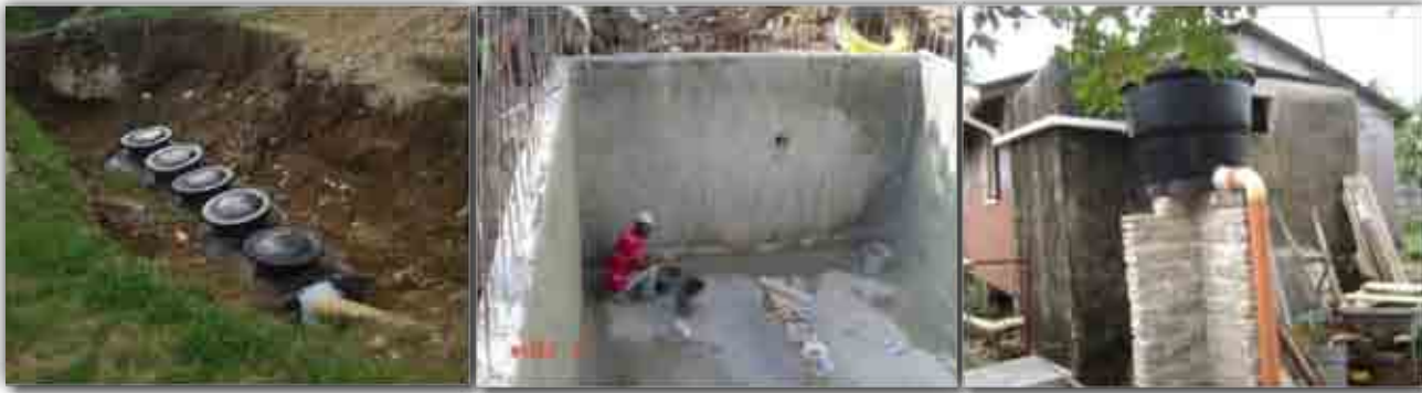
Figura 43. Obras de construcción del SMIA
