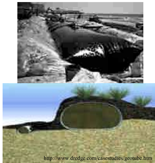
Figura 3. Llenado de un geotubo, con un corte transversal esquemático.
